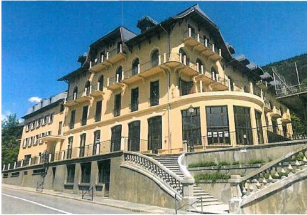
Bâti remarquable identifié suite à la modification du PLU
